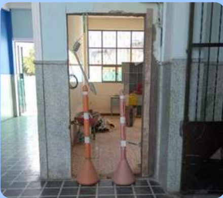
Zona paso a estadio Bachillerato
